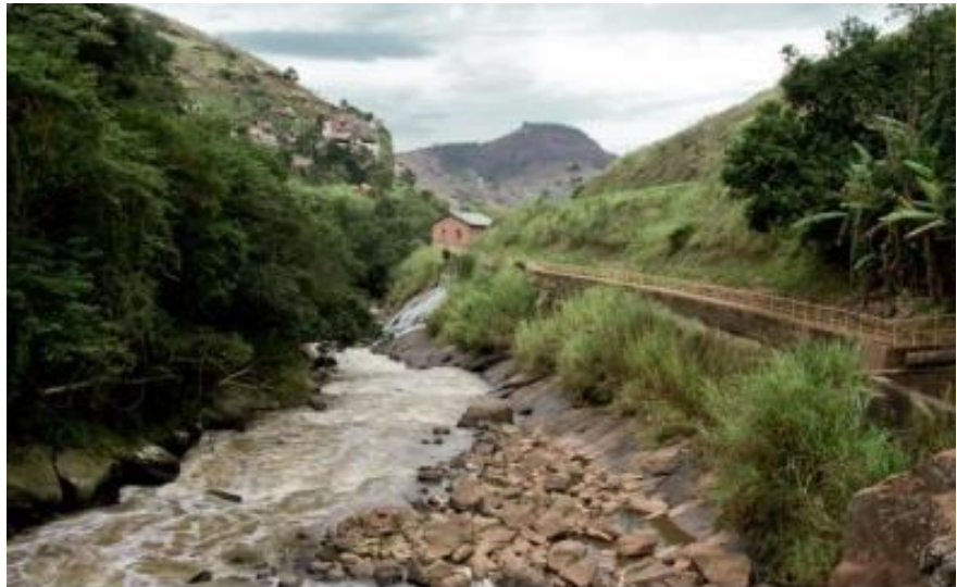
Figura 2 – Usina de Marmelos Zero – Primeira usina hidrelétrica destinada ao serviço público da América do Sul.
